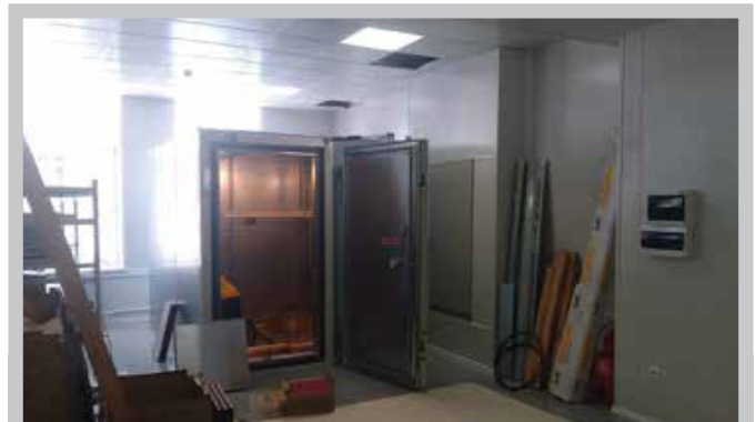
Рисунок 2 Камеры устанавливаются в новом отремонтированном помещении
